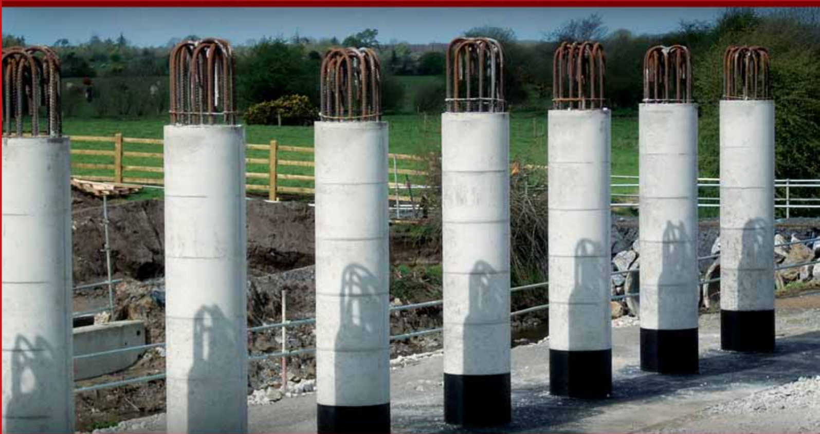
A 1ª cofragem em plástico para colunas redondas
